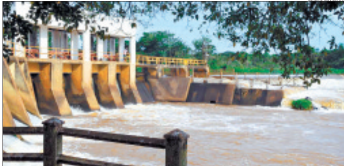
Barragem da desativada Usina Emas Nova, no Rio Mogi-Guaçu, em Pirassununga: PCH aguarda, desde 2008, sua licença
